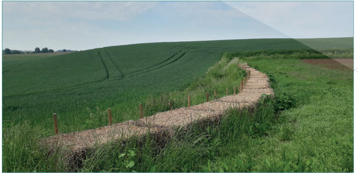
Een strobalemdam en grasstrook langs een akker in de buurt van de Langegracht
